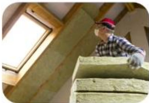
Schuin dakisolatie binnenzijde
