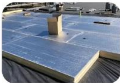
Plat dakisolatie buitenzijde
