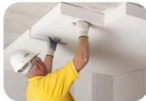
Plat dakisolatie binnenzijde
